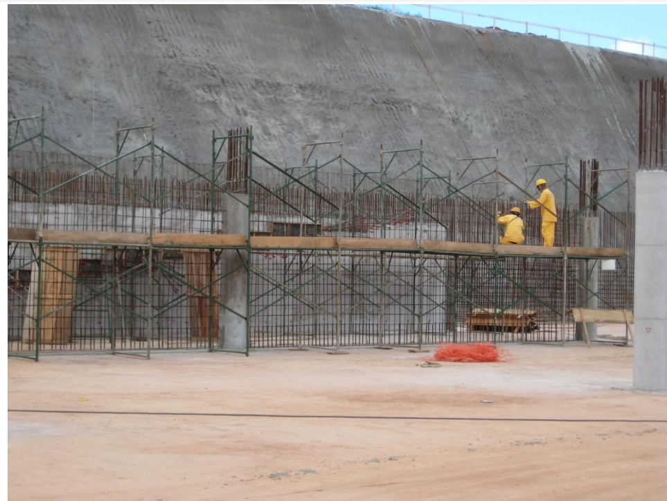
Foto 15 –Armação Paredes 13, 14, 15 e16- 3º subsolo, trecho V, ref. Item 03.02.500 no Memorial descritivo
