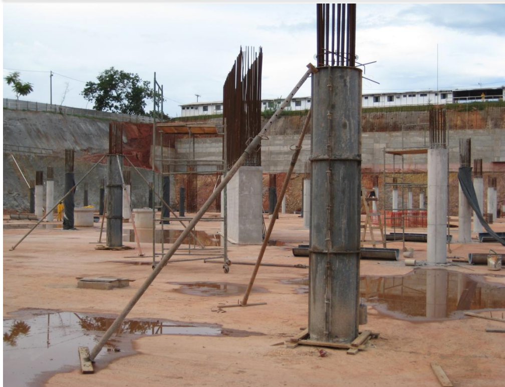
Foto 12 – Forma circular Pilares 3º subsolo, trecho IV, ref. Item 03.02.110.1.01 no Memorial descritivo
