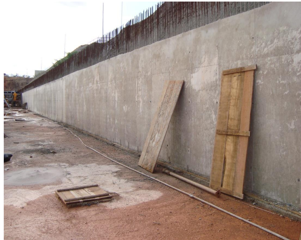
Foto 25 – Concreto Paredes 5-eixo 14 3º subsolo, trecho V, ref. Item 03.02.700 no Memorial descritivo
