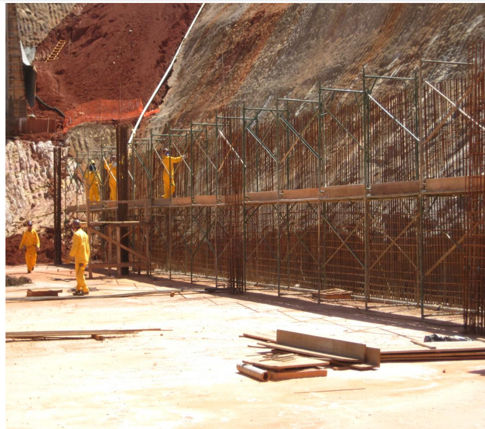
Foto 3 – Aço horizontal da parede 10(cortina) eixo X do eixo 3 ao 8 do nível 1044,72 ao 1046- trecho III, ref. Item 03.01.600 no Memorial descritivo
