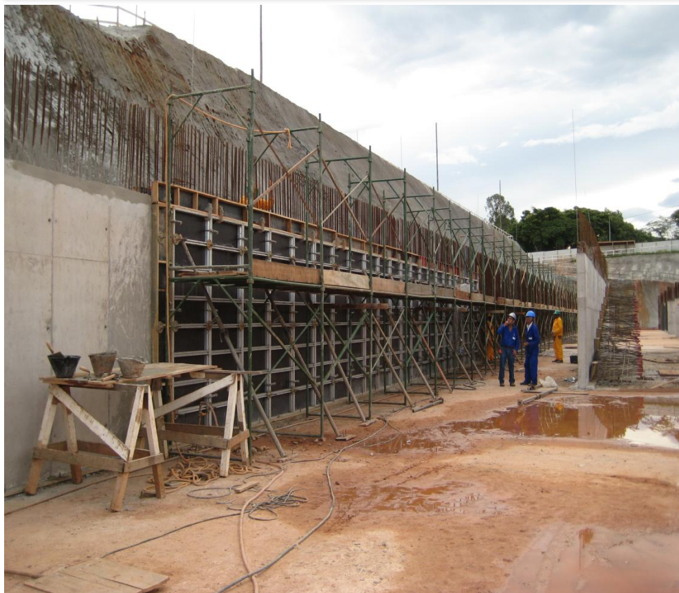
Foto 2 – Forma parede 5(cortina)-eixo 14, 3º subsolo, trecho V, ref. Item 03.01.600 no Memorial descritivo
