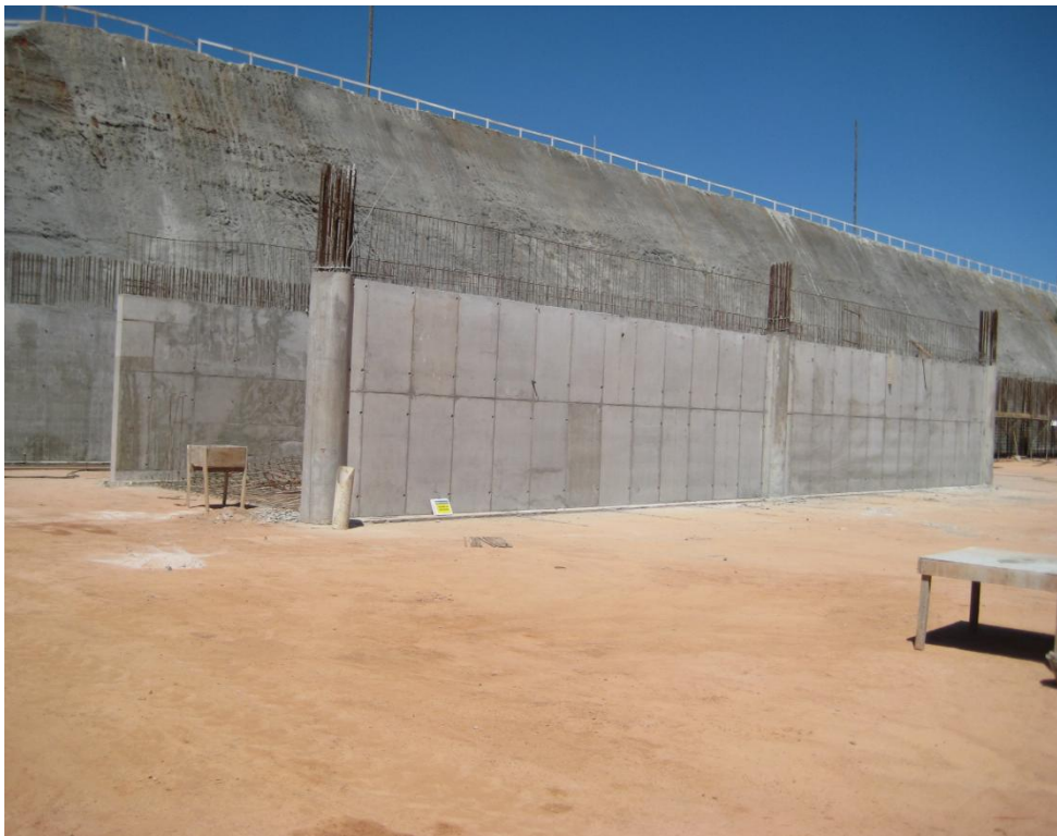
Foto 24 – Concreto Paredes 13 e 15- 3º subsolo, trecho V, ref. Item 03.02.700 no Memorial descritivo
