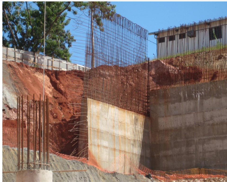
Foto 5 – Armação cortina eixo A, trecho I (4,00 m excedente acima dos 7,20m), ref. Item 03.01.600 no Memorial descritivo
