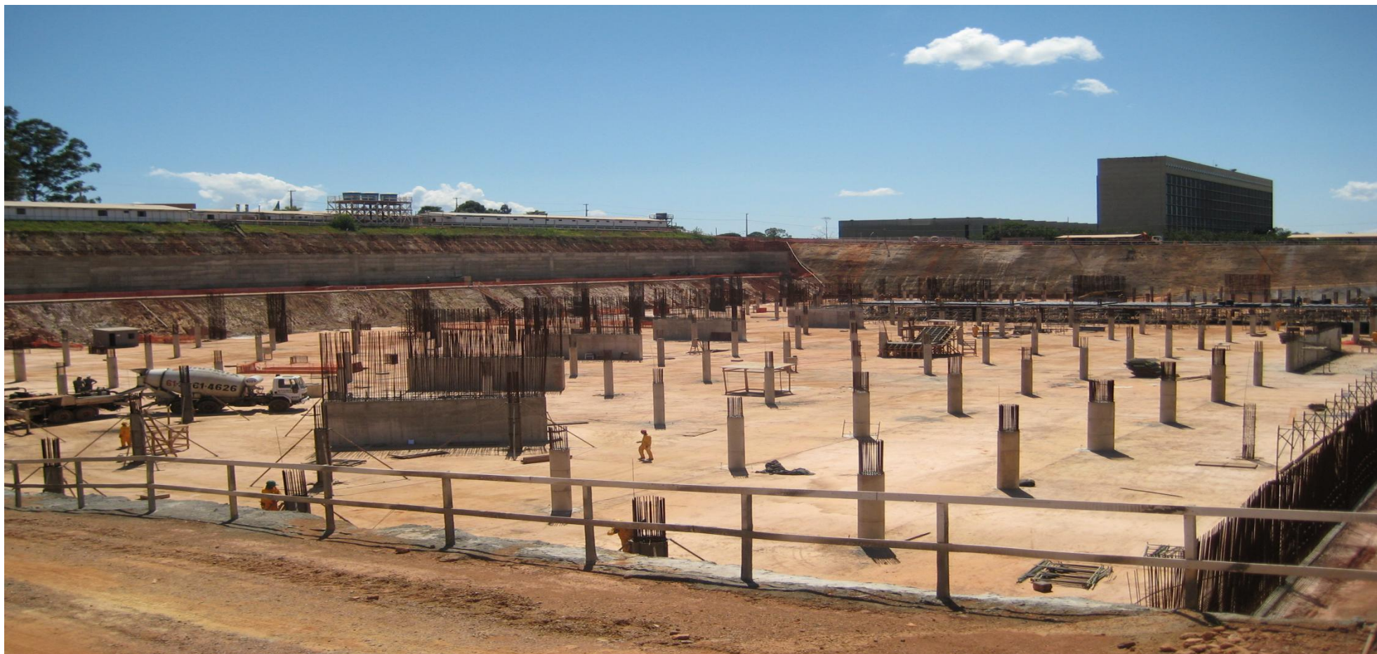
Foto 1 – Vista Geral da Obra
