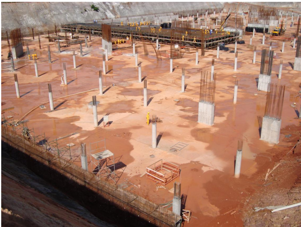
Foto 22 – Concreto Pilares Retangulares 3º subsolo, trecho III, eixos O,S,U., ref. Item 03.02.700 no Memorial descritivo
