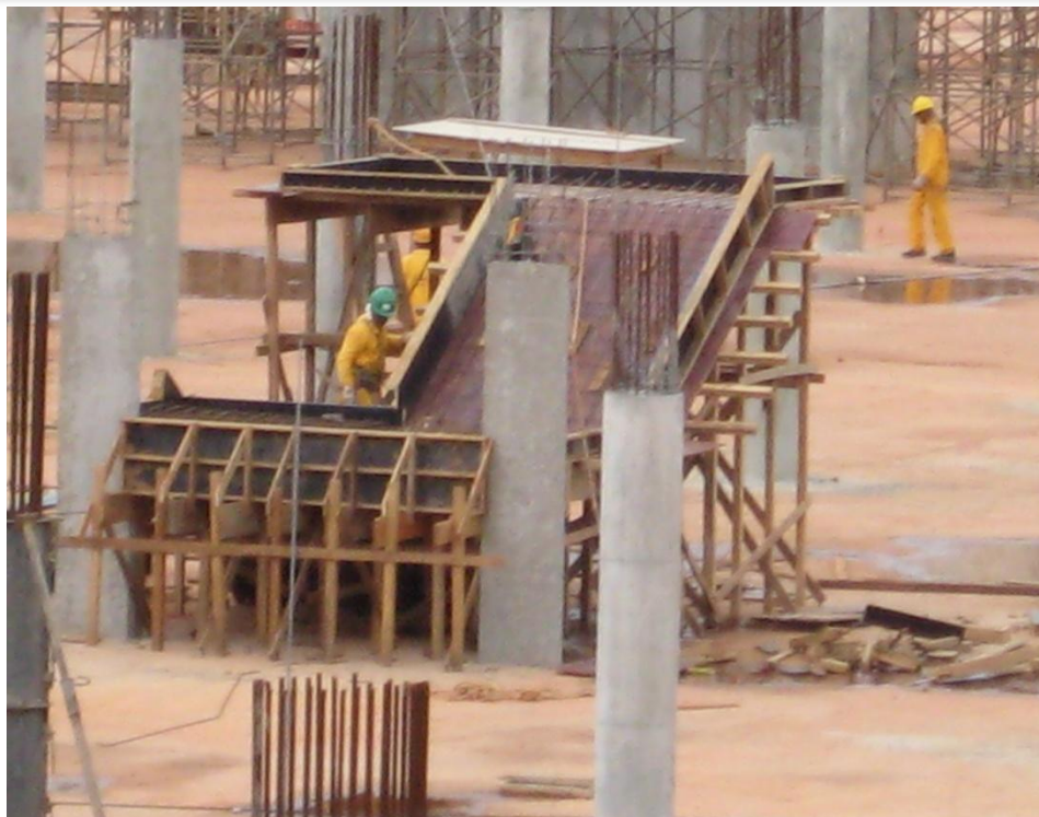
Foto 18 – Armação Escada E-8 do 3º para o 2º Subsolo- trecho V, ref. Item 03.02.500 no Memorial descritivo
