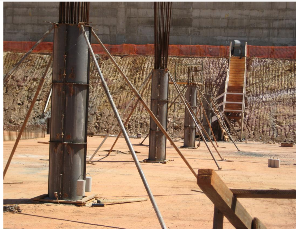
Foto 11 – Forma circular pilares 3º subsolo, trecho II ref. Item 03.02.110.1.01 no Memorial descritivo
