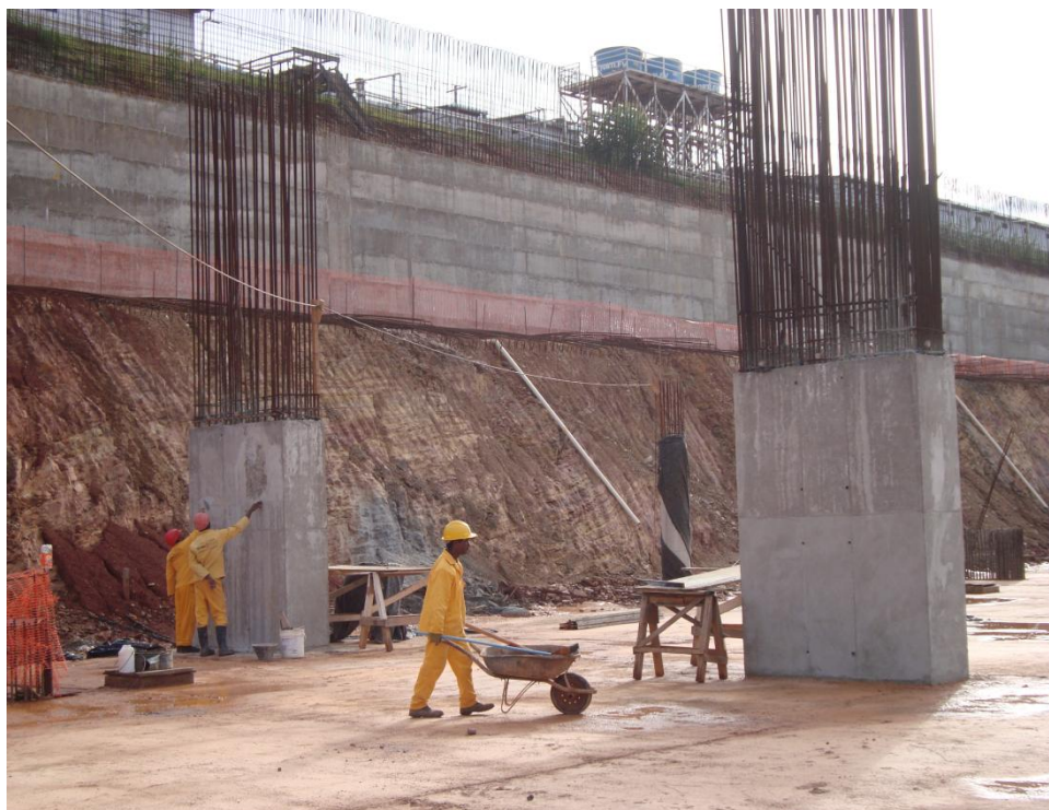
Foto 20 – Concreto Pilares Retangulares 3º subsolo, trecho I, entre eixos C - E / 3 – 4, ref. Item 03.02.700 no Memorial descritivo
