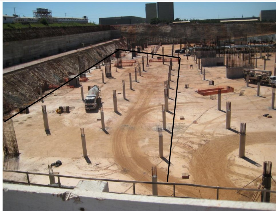
Foto 19 – Concreto Pilares circulares 3º subsolo, trecho I, entre eixos 3 e 5, ref. Item 03.02.700 no Memorial descritivo
