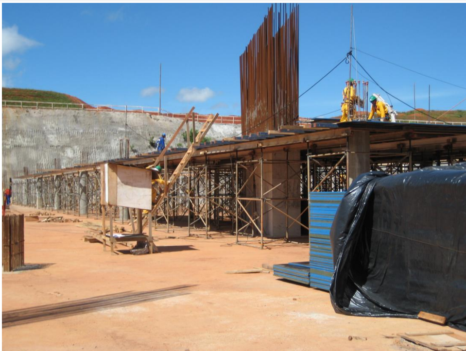
Foto 14 – Cimbramento metálico 3º subsolo, Faixa entre os eixos N-O /7-13 e O-P /7-14-trecho V, ref. Item 03.02.400 no Memorial descritivo
