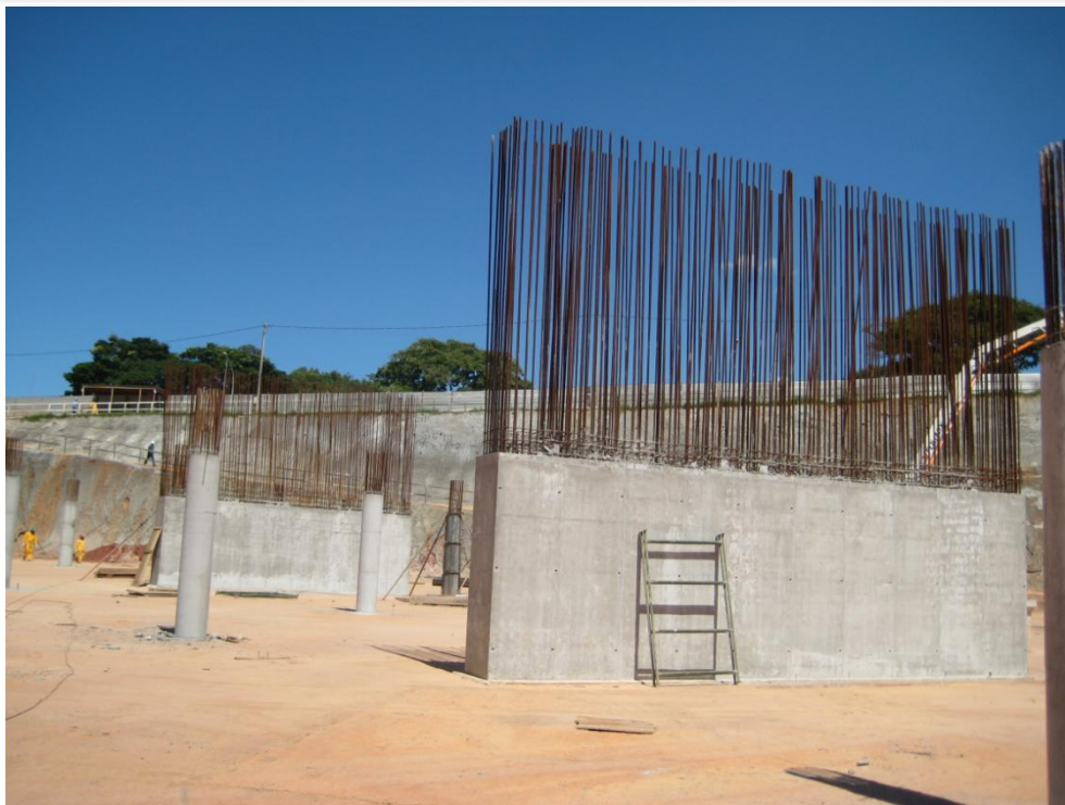
Foto 16 – Aço vertical do nível 1046,325 ao 1049,50 dos pilares retangulares entre os eixos 8-11 e C-G trecho IV, ref. Item 03.02.500 no Memorial descritivo
