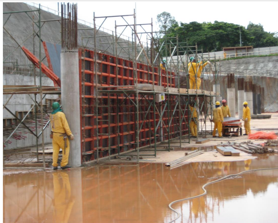
Foto 13 – Forma Paredes 13 e 15- 3º subsolo, trecho V, ref. Item 03.02.110.1.02 no Memorial descritivo
